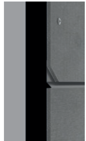
Listalla tiivistetty liitos
