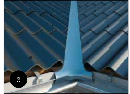
3 Skotrenden er en udsat del af tagkonstruktionen. Se side 21.
