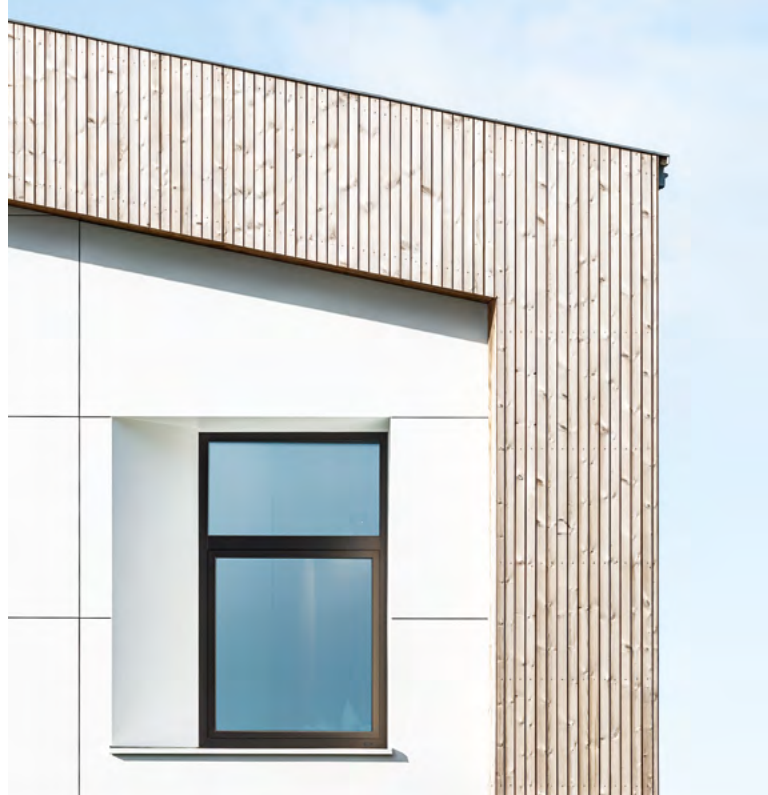
Skryté kotvení s použitím systému Swisspearl Sigma 8 Pro
