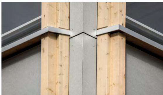
Viditelná montáž v kombinaci se systémem Uzavřený roh 90°
