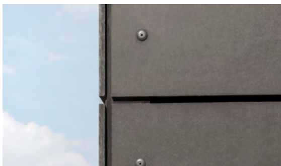
Viditelné kotvení vláknocementových desek s použitím barevných nýtů
