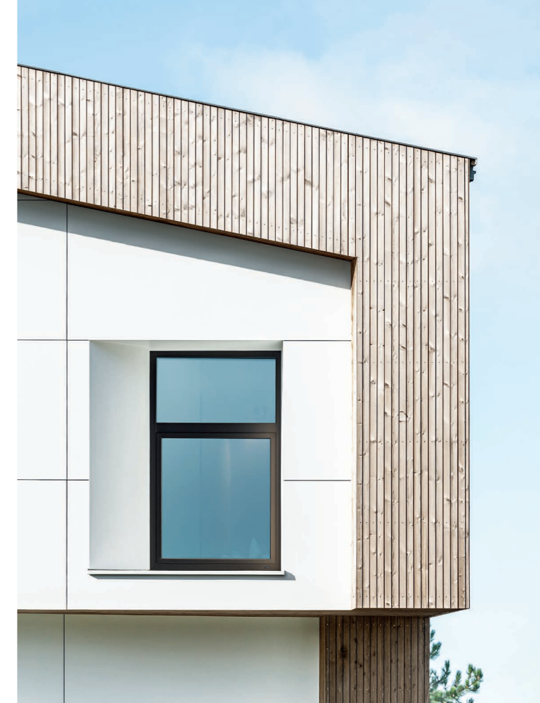
Skjult montage med Swisspearl Sigma 8 Pro System
