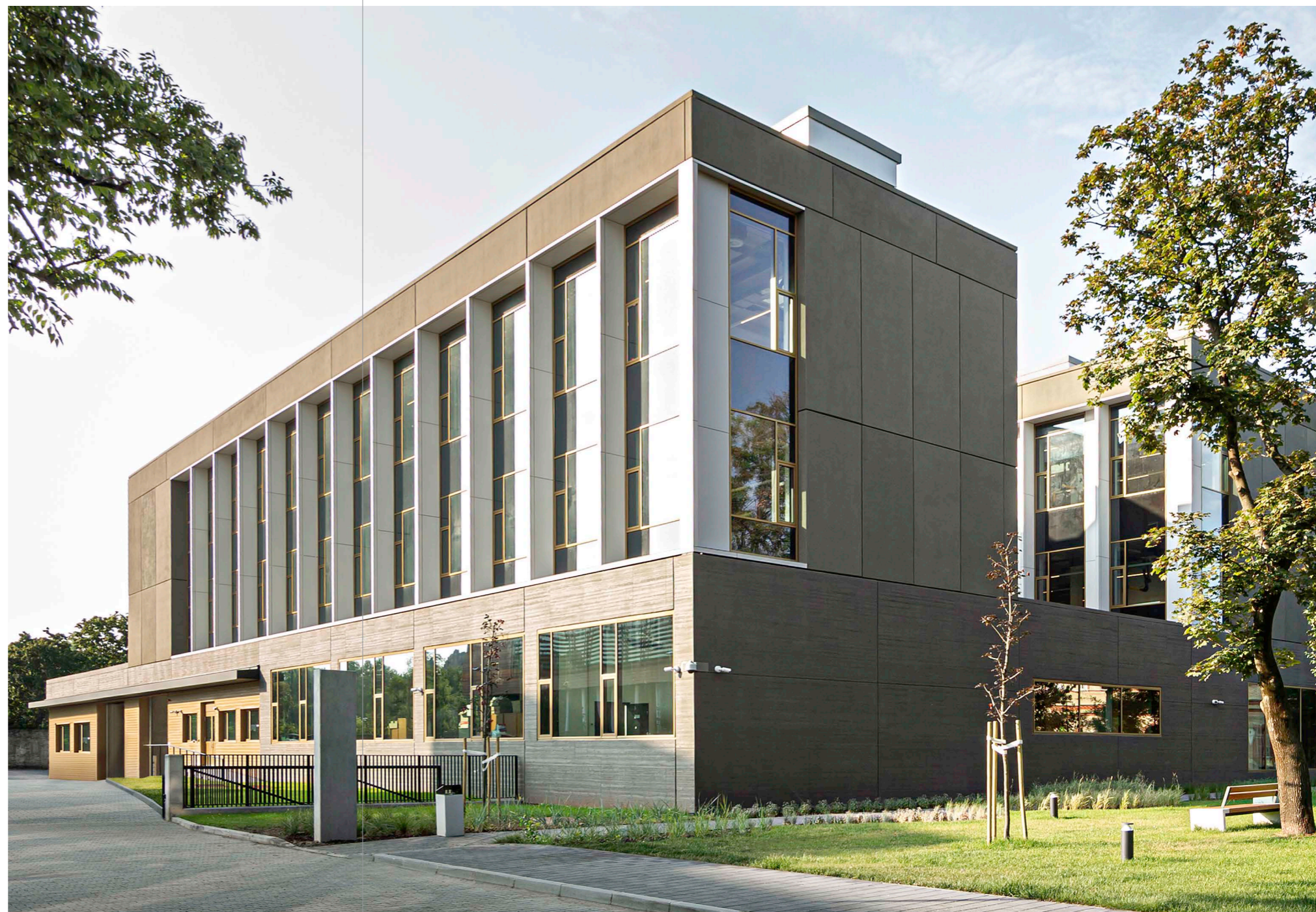
National Museum Restoration and Storage Center, Budapest, Ungarn. Arkitekt: Narmar Építészeti Stúdió, Budapest, Ungarn. Fotograf: Meraner & Hauser OHG / SNC, Bozen, Italien.
