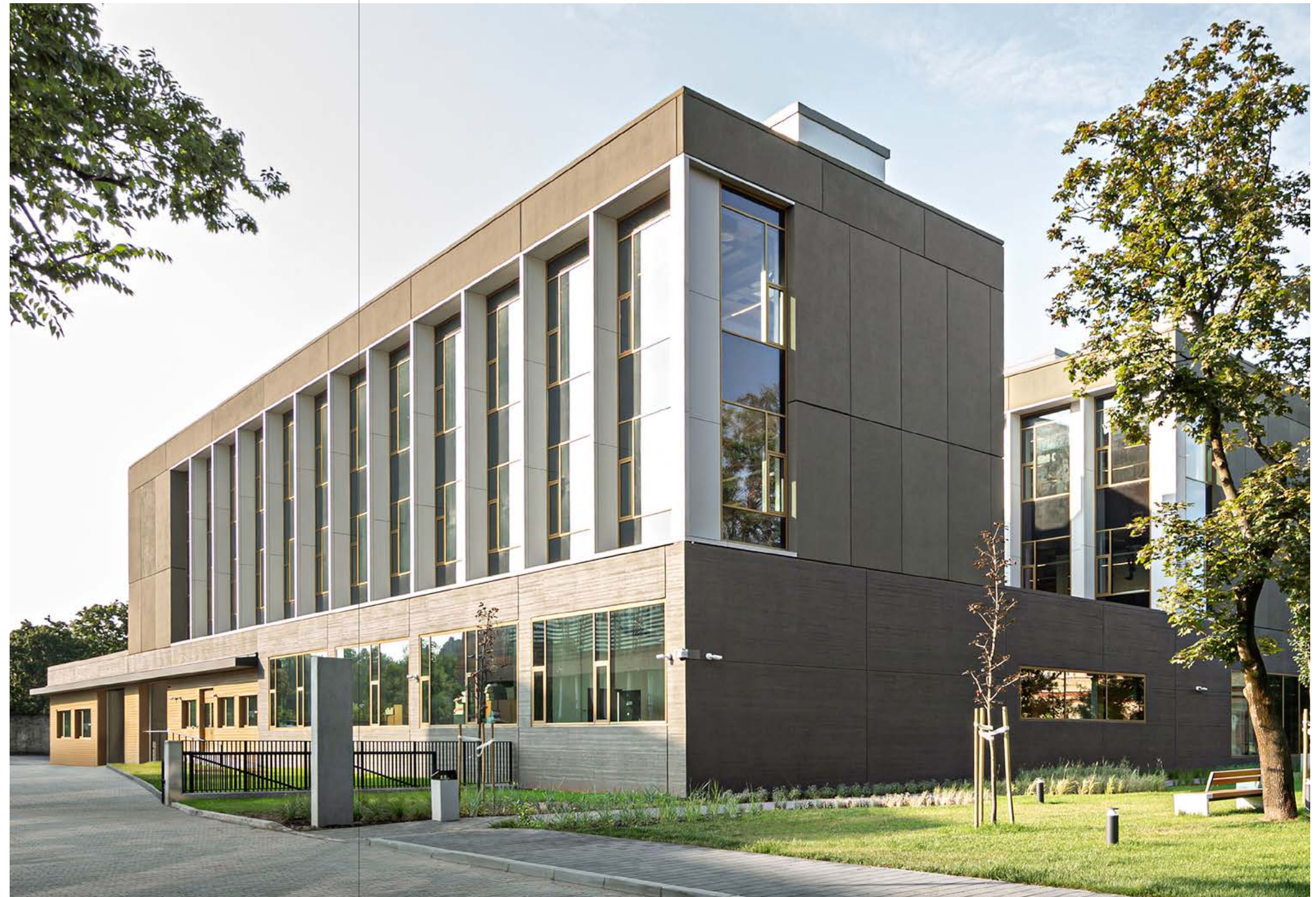
Musée national OMRRK, Budapest, Hongrie. Architecte : Narmer Építészeti Stúdió, Budapest, Hongrie. Photographe : Meraner & Hauser OHG/SNC, Bolzano, Italie.
