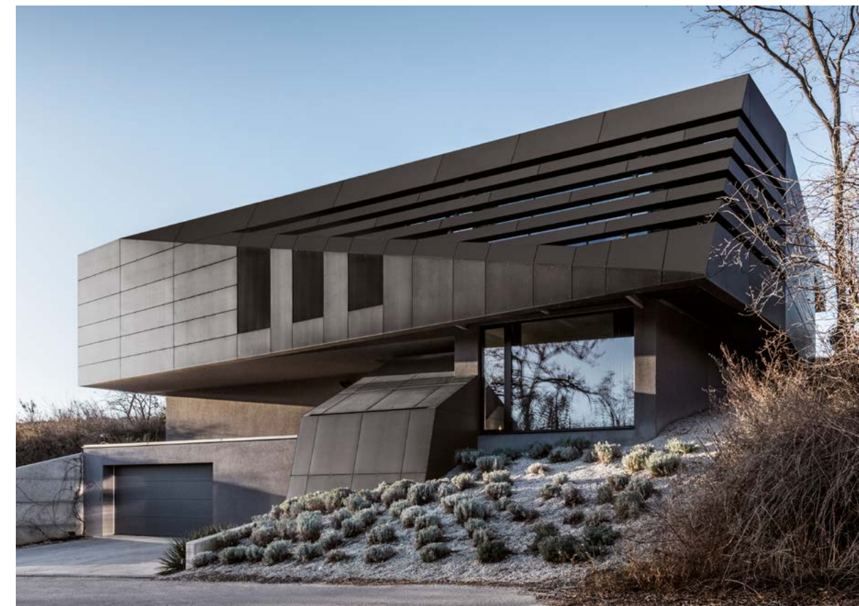
House RnEve, Mönchhof, Austria. Architekt: ad2 Architekten, Weiden am See, Austria. Zdjęcia: Meraner & Hauser OHG/SNC, Bolzano, Włochy
