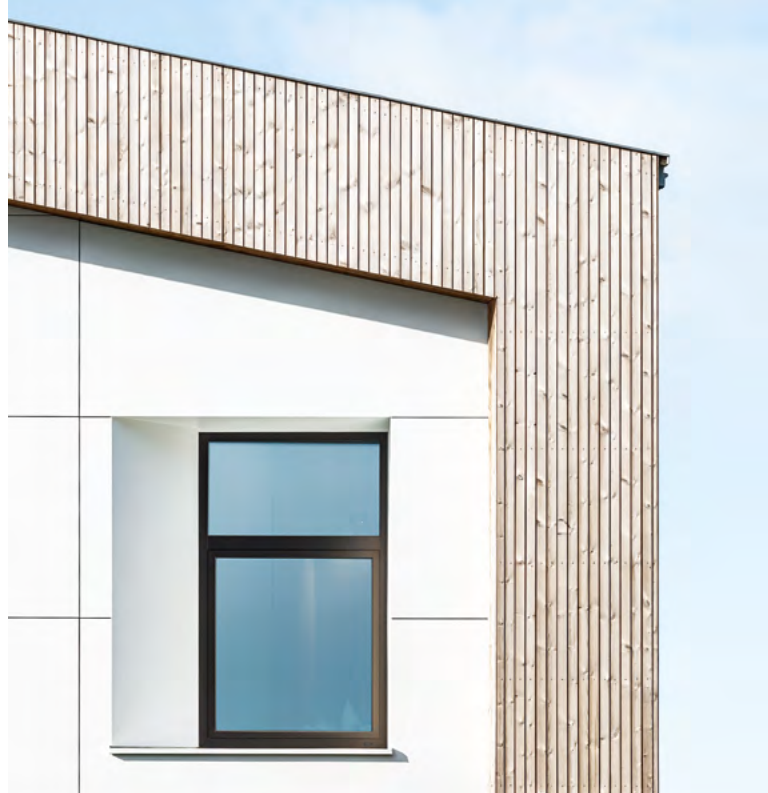
Montaż niewidoczny z zastosowaniem systemu Swisspearl Sigma 8 Pro
