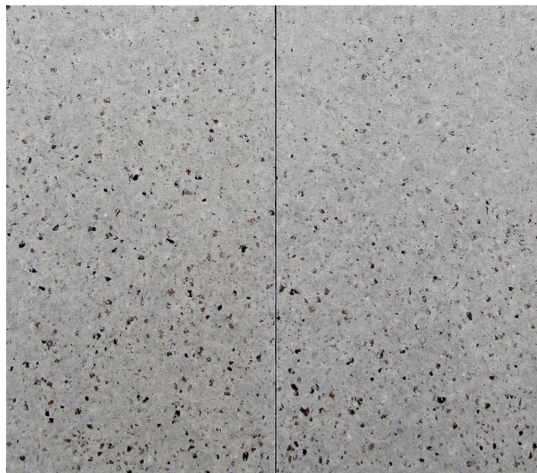
Fog med raka kanter ställ högre toleranskrav
