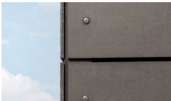
Matomas pluoštinio cemento plokščių tvirtinimas naudojant spalvotas kniedes
