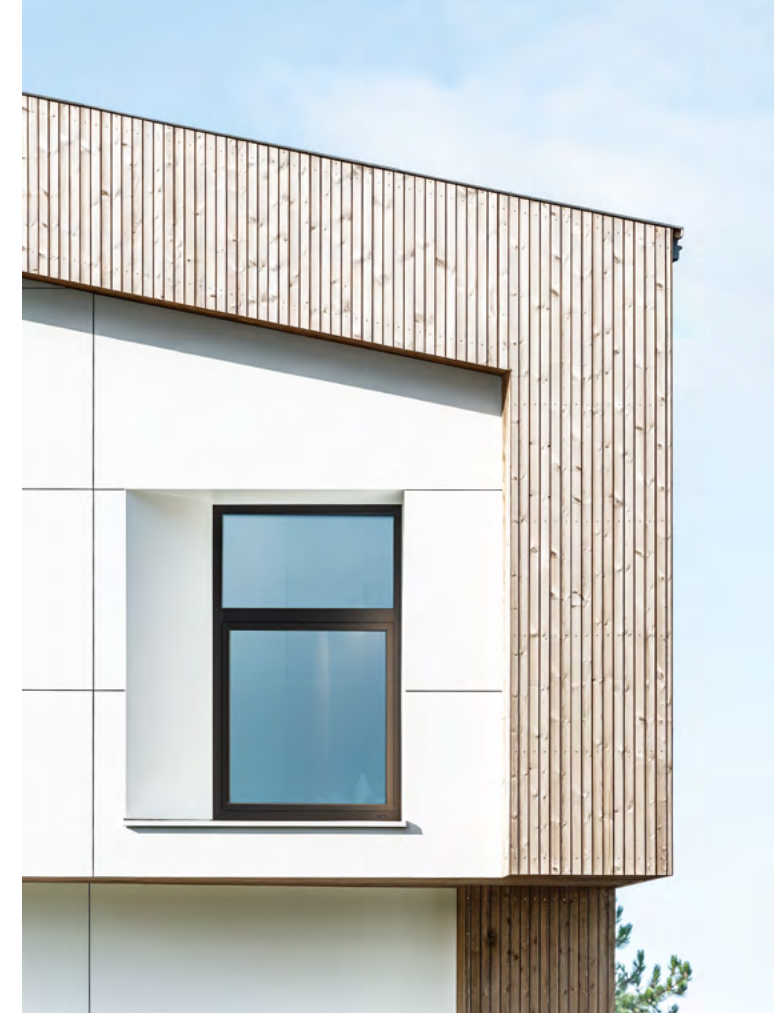
Nematomas tvirtinimas, naudojant „Swisspearl Sigma 8 Pro“ sistemą
