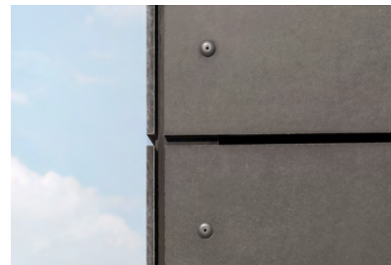
Matomas pluoštinio cemento plokščių su dažytomis kniedėmis tvirtinimas
