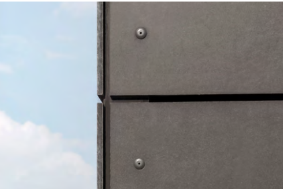
Nähtava neetkinnitusega kiudtsementplaadid
