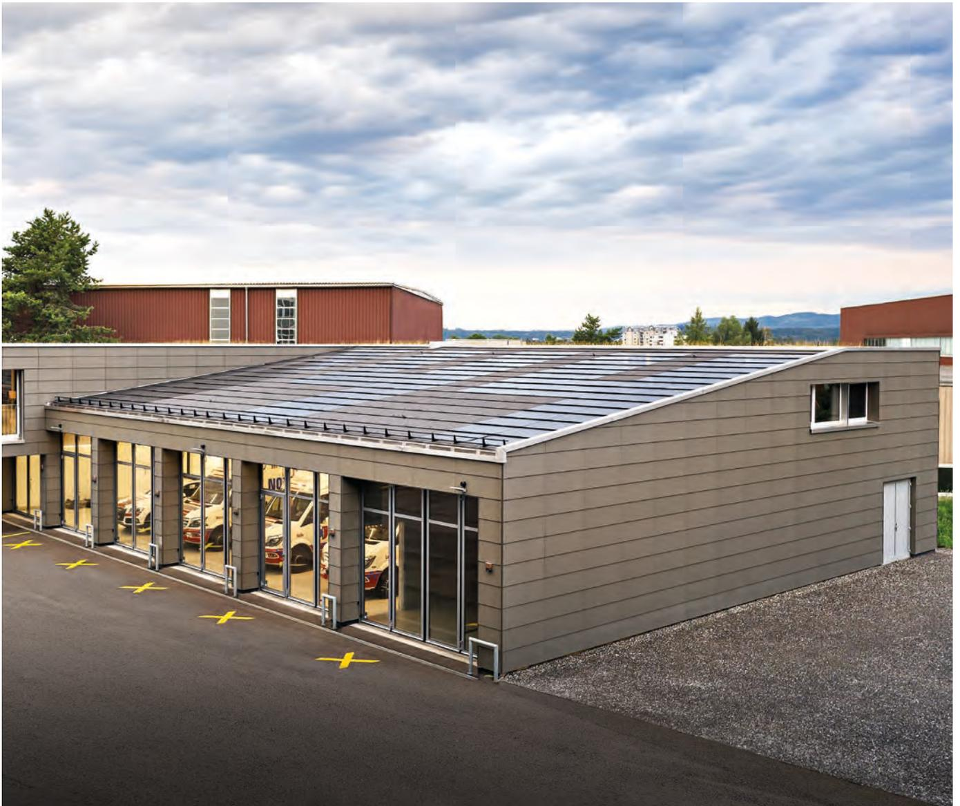
Sunskin Roof Lap in Verbindung mit Aura-Ergänzungsplatten auf dem Dach.
