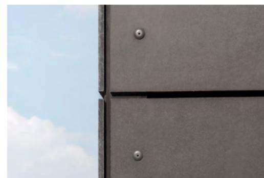
Sichtbare Befestigung der Faserzementplatten mit eingefärbten Nieten
