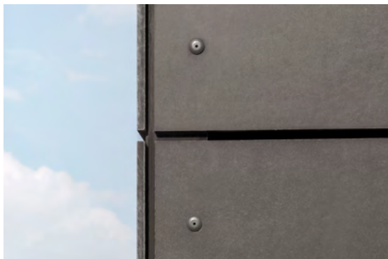
Sichtbare Befestigung der Faserzementplatten mit eingefärbten Nieten
