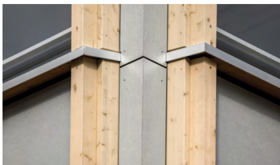
Sichtbare Befestigung in Kombination mit dem System der Geschlossenen 90°-Ecke
