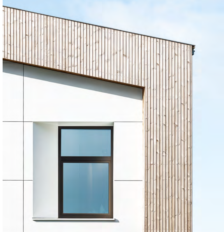
Unsichtbare Befestigung mit dem Swisspearl Sigma 8 Pro System
