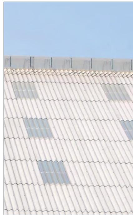
Větrání střešního pláště je realizováno hřebenem střechy. Kapacita větrání je dána profilem vlnité krytiny (pro A5 platí 250 cm<sup>2</sup>/bm). Větrací otvor vznikne mezi rovnou plochou hřebenáče a profilem vlnovky. Není použit těsnící profil. Toto řešení je vhodné pro střechy s maximální délkou krokve 6m.
