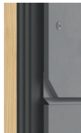
Spáry osazené profilem
