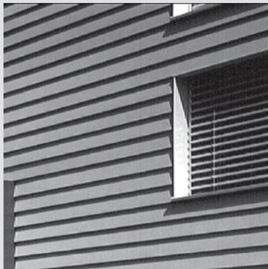
Fassadenplatten voneinander abgesetzt, Befestigung unter der Überlappung.
