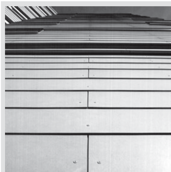
Diskrete Befestigung der gestülpten Fassadenplatten mit gefärbten Nieten.
