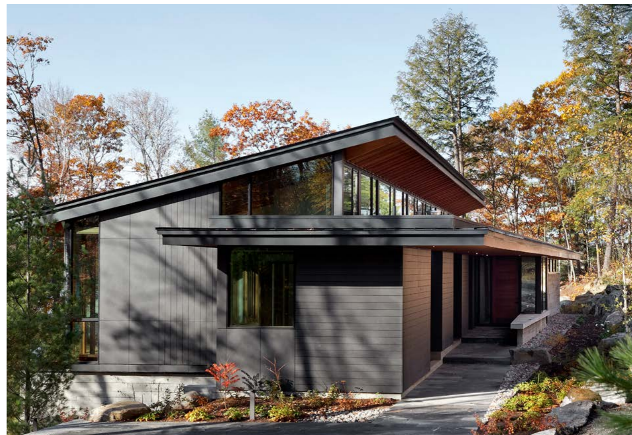
Huis aan Haliburton Lake, Ontario, Canada. Architect: +VG, Toronto, Canada. Fotograaf: David Whittaker Photographer Inc., Toronto, Canada.
