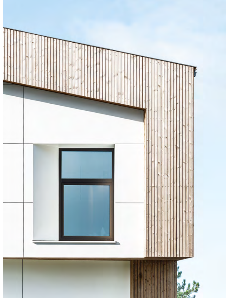
Onzichtbare montage met het Swisspearl Sigma 8 Pro-systeem
