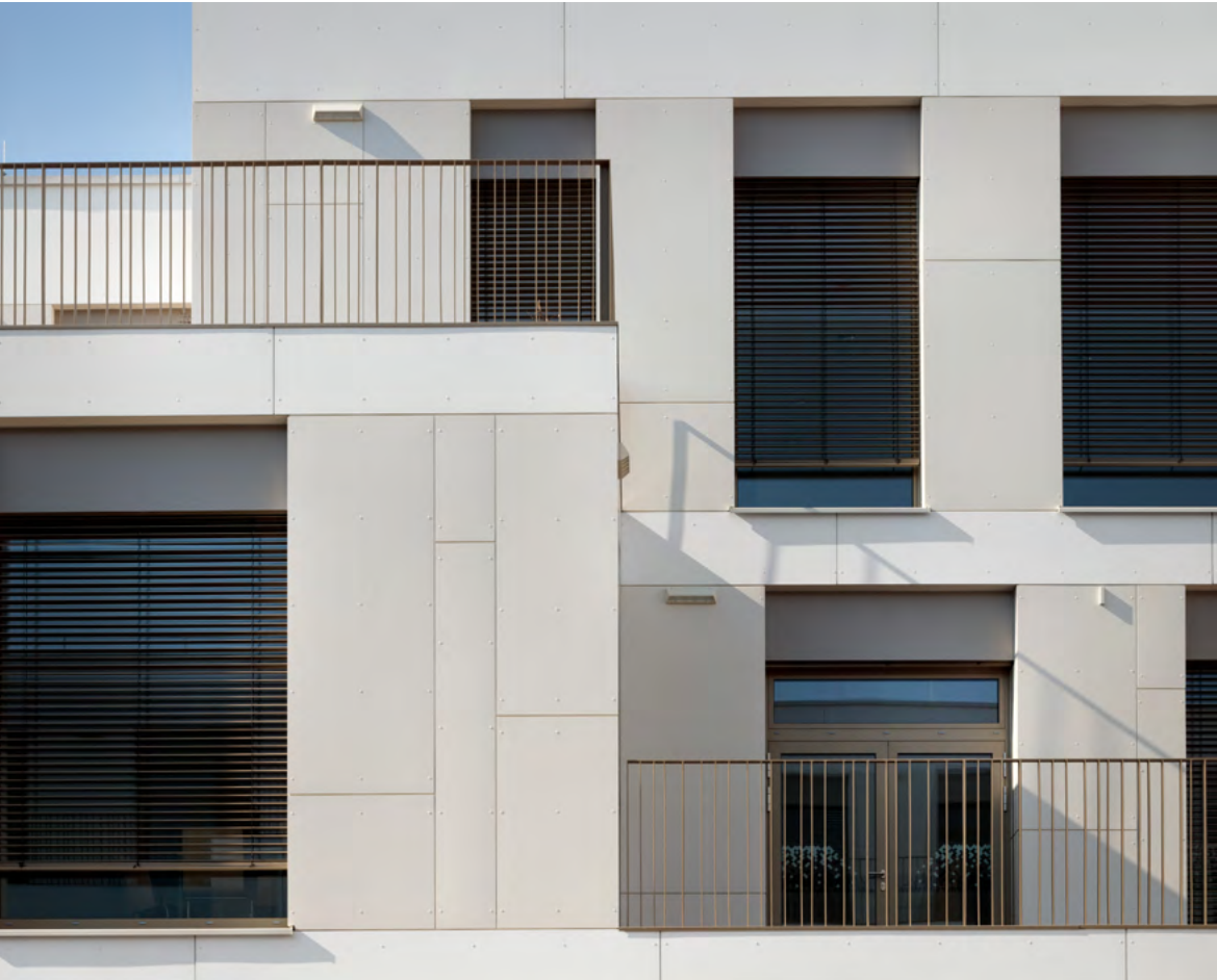
AHS Wien West, Vienna, Austrija. Arhitekts: Shibukawa Eder Architects / FP Architekten, Vienna, Austrija. Fotogrāfs: Kurt Kuball, Vienna, Austrija.
