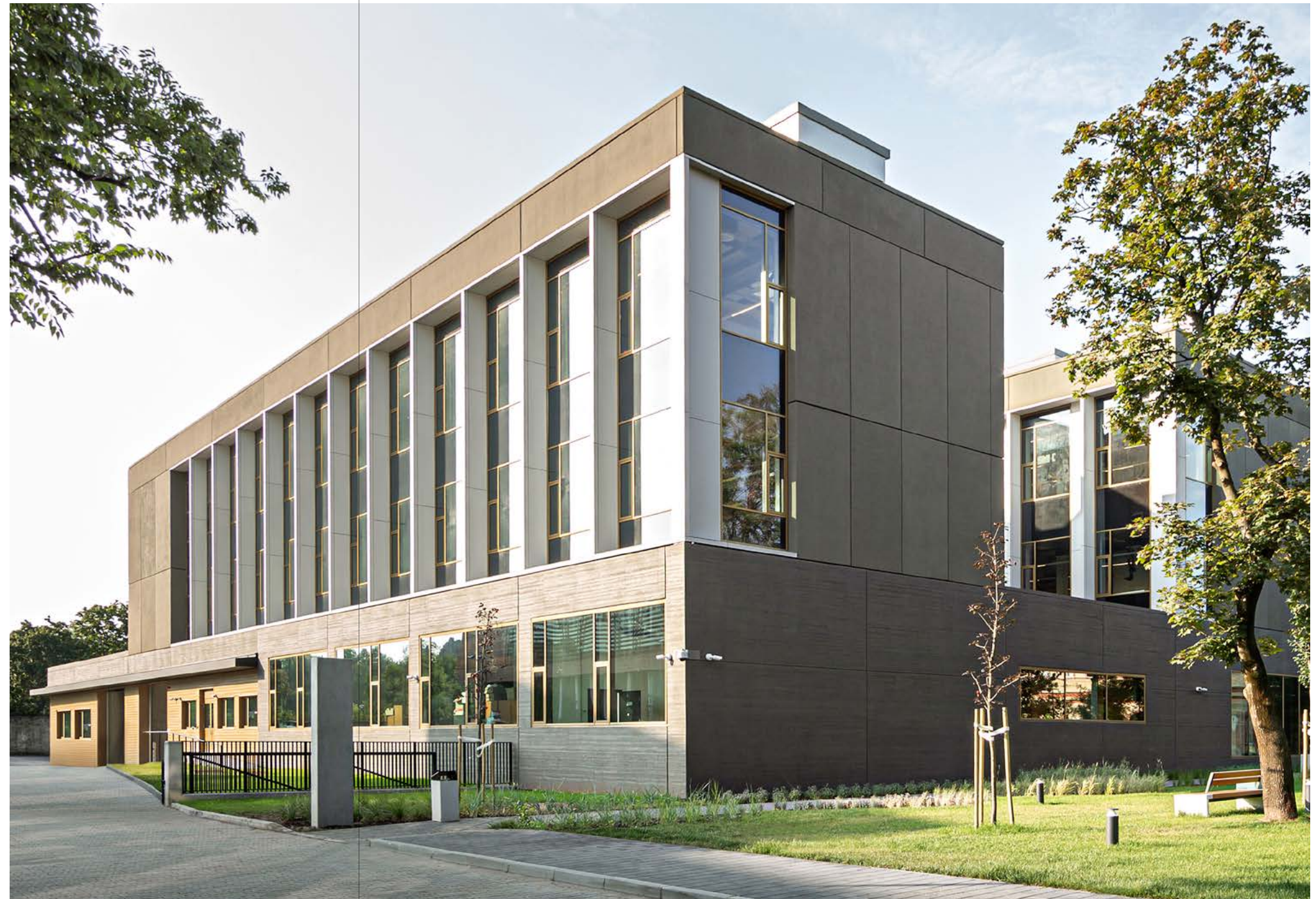
Musée national OMRK, Budapest, Hongrie. Architecte : Narmer Építészeti Stúdió, Budapest, Hongrie. Photographe : Meraner & Hauser OHG/SNC, Bolzano, Italie.
