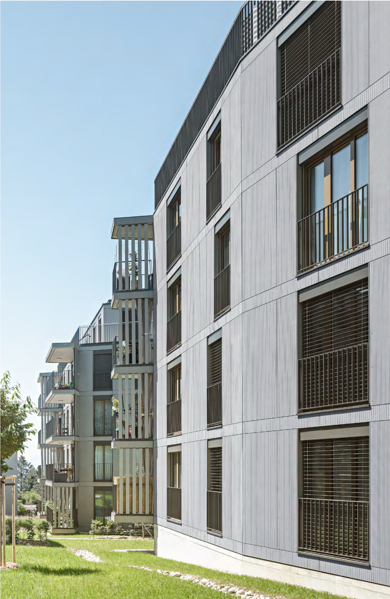
Fiches Nord, Lausanne, Suisse, Architecte : Züst Gübeli Gambetti Architektur und Städtebau AG, Zurich, Suisse, Photographe : Roger Frei, Zurich, Suisse.
