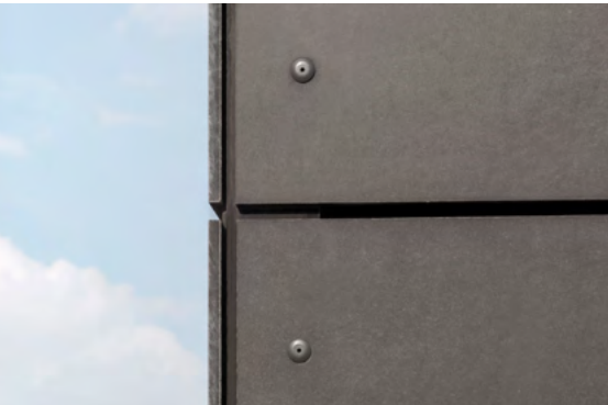
Montage visible des panneaux en fibres-ciment avec des rivets colorés
