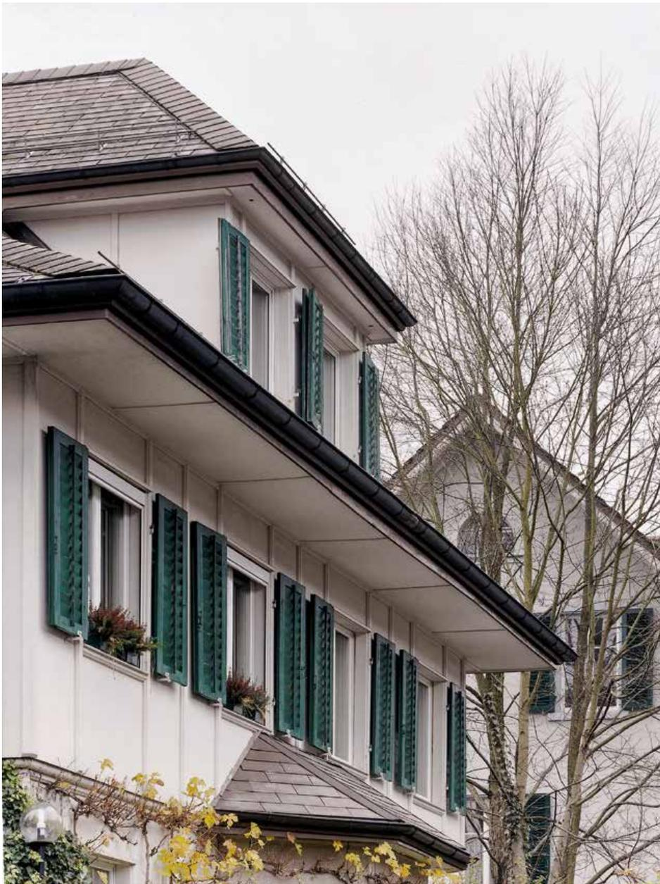
Die Umfassungswände messen 25 Zentimeter, verfügen über eine ein Zentimeter starke Eternitverschalung – was nach Angaben der Architekten kostengünstiger, wetterdichter und mindestens so isolierend wie ein 38 Zentimeter dickes konventionelles Mauerwerk sei. Die Plattenfugen sind mit 15 Zentimeter breiten, gestrichenen Holzleisten abgedeckt.
