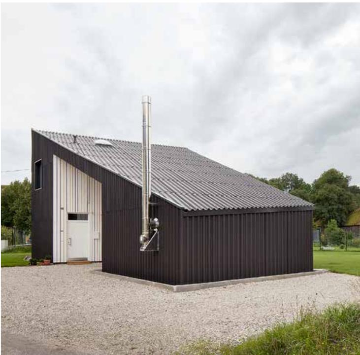
Eine einheitliche Wellplattenverkleidung umfasst Haus und Nebengebäude und überspannt einen offenen Leerraum dazwischen.
