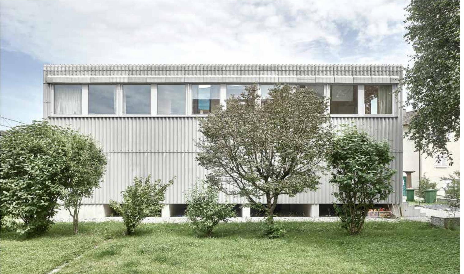
Das Obergeschoss des im Split-Level organisierten Hauses öffnet sich an beiden Längsseiten in der vollen Länge mit Bandfenstern.
