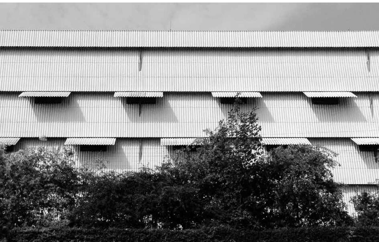
Umspannwerk Amager (1963/64) mit aufgeklappten Faserzementplatten zum Schutz der Öffnungen.
