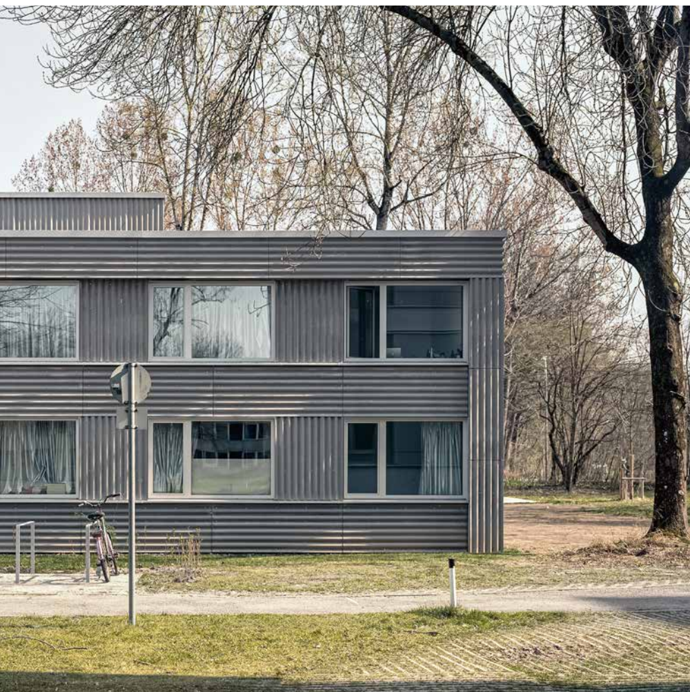
Der Wechsel in der Verle- gerichtung der gewellten Faserzementplatten bildet die «statischen» Prinzipien der Originalfassaden ab.
