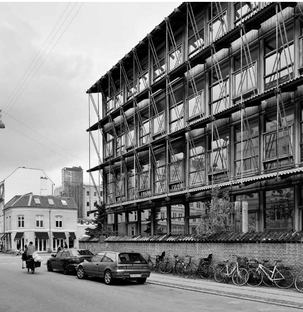
Erweiterung der Gasværksvejens-Schule (1967–1971).
