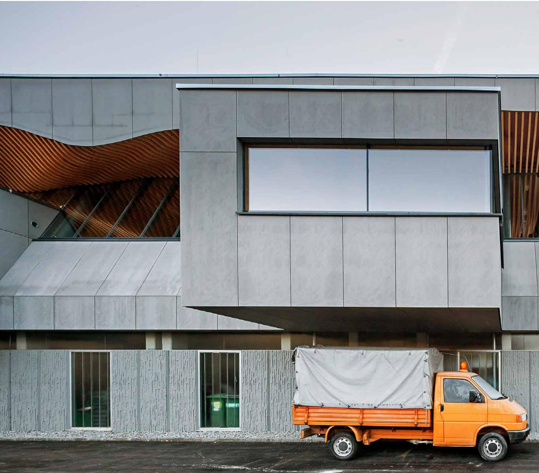
Wie der Sichtbeton sind die unbehandelten Faserzementplatten im nassen Zustand dunkler als im trockenen. Die Sichtbetonfassade im Erdgeschoss ist noch original aus den 1970er-Jahren.
