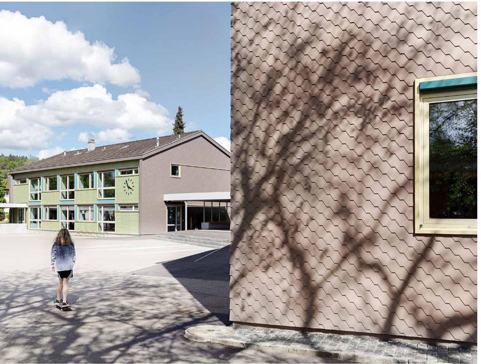
Ein Fest der Farben: Durch die wechselseitige Verlegung der kleinformatischen Faserzementplatten in jeweils zwei Farbtönen, mal Grün und Gelb, mal Grün und Blau, entstehen changierende Muster.
