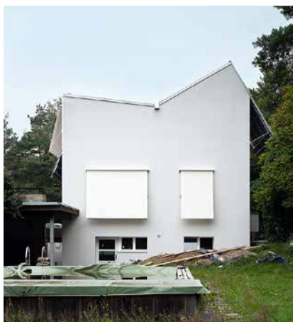
Dans le cadre de la maison individuelle de Bassersdorf, des parois extérieures en dur furent combinées avec une toiture légère en éléments de bois et des avant-toits en plaques de fibres-ciment.
