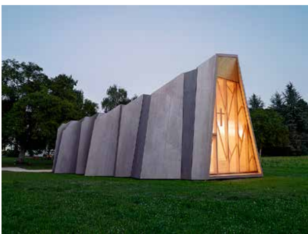
La chapelle Saint-Loup, 2008, est réalisée avec des panneaux contrecollés en bois massif.
