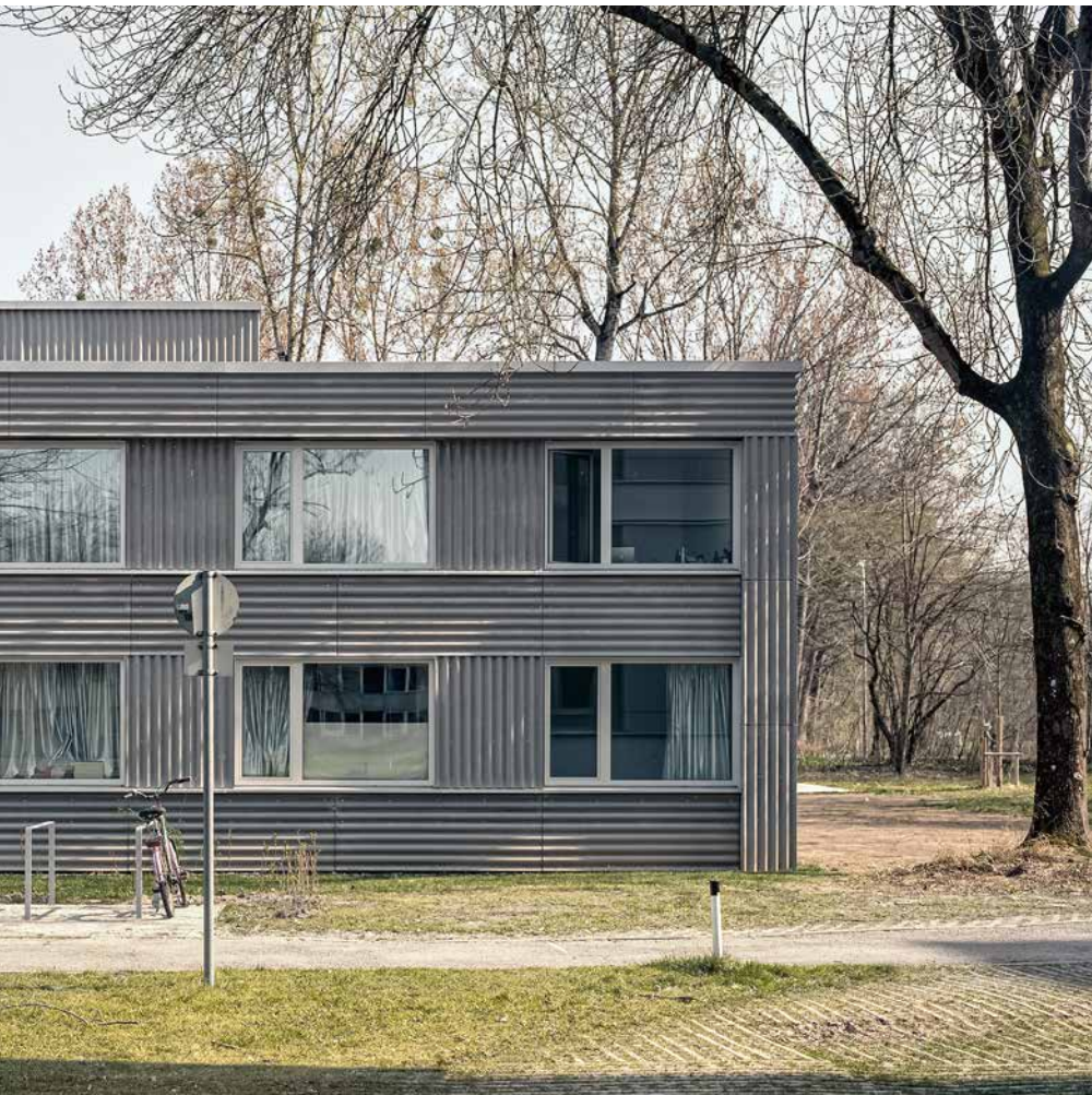
L'alternance au niveau de l'orientation des plaques de fibres-ciment ondulées durant la pose évoque les principes «statiques» de la façade d'origine des maisons à atrium.
