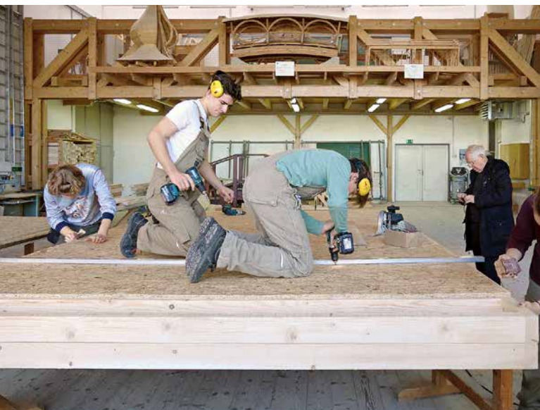
Dans les ateliers de la HTL Mödling près de Vienne, les élèves réalisèrent les parois en bois destinées au nouveau village d’habitation.
