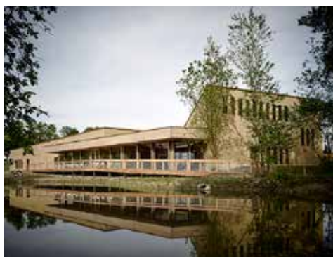
Réalisation du centre des visiteurs de la Station ornithologique suisse de Sempach, 2013-2015
