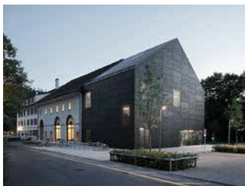
Ecole cantonale de Wettingen, réalisation d'un réfectoire, Wettingen, 2007/08
