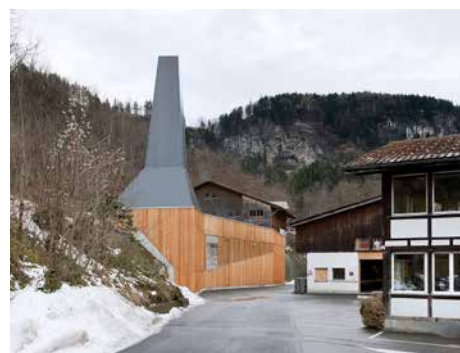
Centrale de chauffage, Lungern
