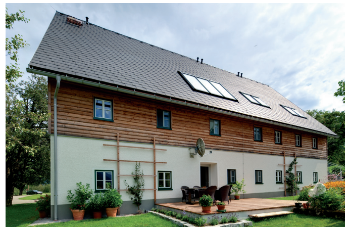
Wohnhaus vor und nach der Sanierung mit der Eternit Dachplatte ED RE 40/60 Fotografie: Swisspearl
