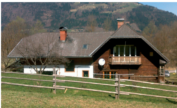
Wohnhaus vor und nach der Sanierung mit der Eternit Dachplatte DD Rechteck 40/30 vollkantig Architektur und Fotografie: DI Stefan Thalmann
