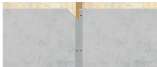
Voegen van afgezaagde panelen moeten worden afgeplakt
