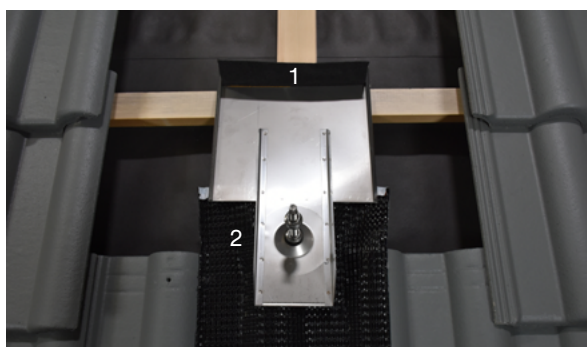
1 Universal-Dichtungskeil setzen 2 Schürze festkleben
