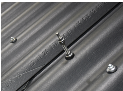
Stockschraube bei Wellplatte P6
