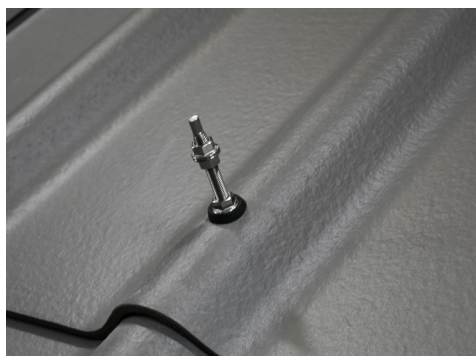
Stockschraube bei Structa Dachplatte
