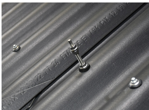
Stockschraube bei Wellplatte P6
