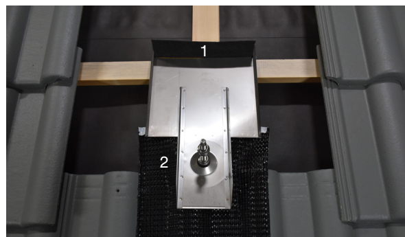
1 Universal-Dichtungskeil setzen 2 Schürze festkleben
