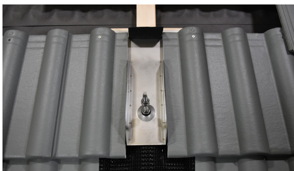
Die weiteren Dachsteine beidecken
