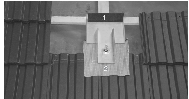
1 Universal-Dichtungskeil setzen 2 Schürze festkleben
