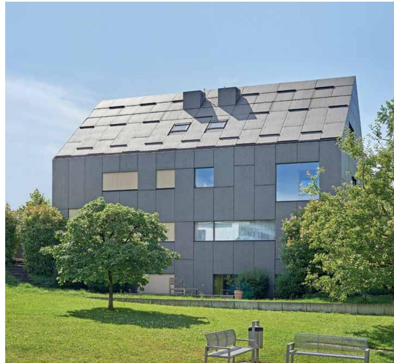
All in one: Dach- und Fassadenlösungen aus Faserzement.
