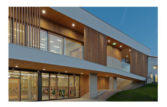
Unter Ausnutzung der Geländestufe in der Topografie des Bauplatzes wurde das 2-geschossige Gebäude so ins Gelände gesetzt, dass es auf beiden Ebenen – im Erdgeschoss und im Obergeschoss – über einen direkten Anschluss an das Terrain verfügt.
