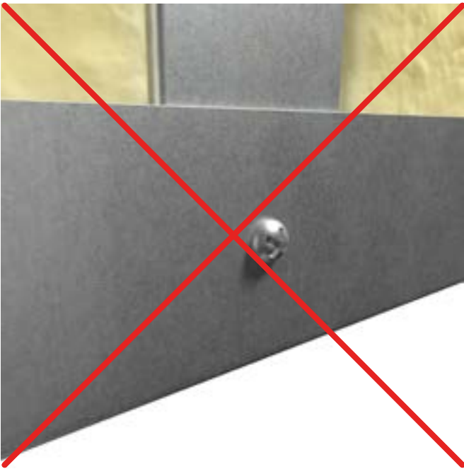
Undvik att använda skruvar med för stora huvuden.
