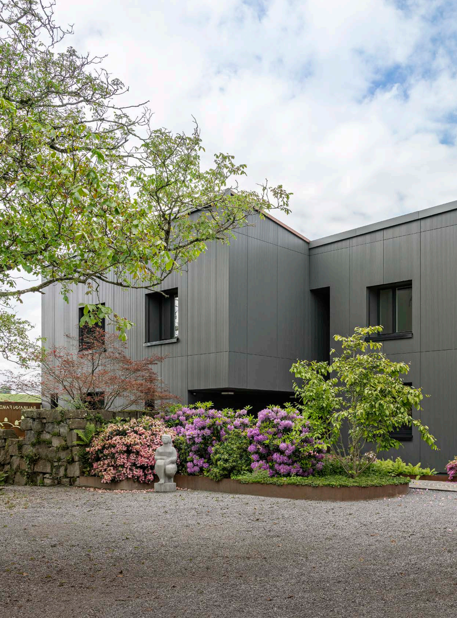
Page de garde et photo ci-dessus : Maison individuelle, Schönenberg. famille de teintes : Gravial. Architecture : ARCHITECTONICA GmbH, Rüschlikon. Photographie : Meraner & Hauser OGH/SNC, Bozen/Italie
