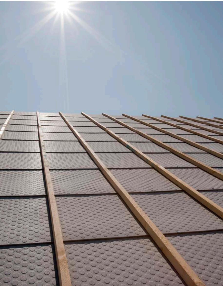
Photo ci-dessus : Plaque de sous-couverture avec profilé / Pages 56 / 57: Maison Panarosa, Arosa. Ardoises de toiture, famille de teintes : Natura. Architecture : Luzius U. Graf, Chur. Photographie : Meraner & Hauser OHG/SNC, Bolzano/Italie
