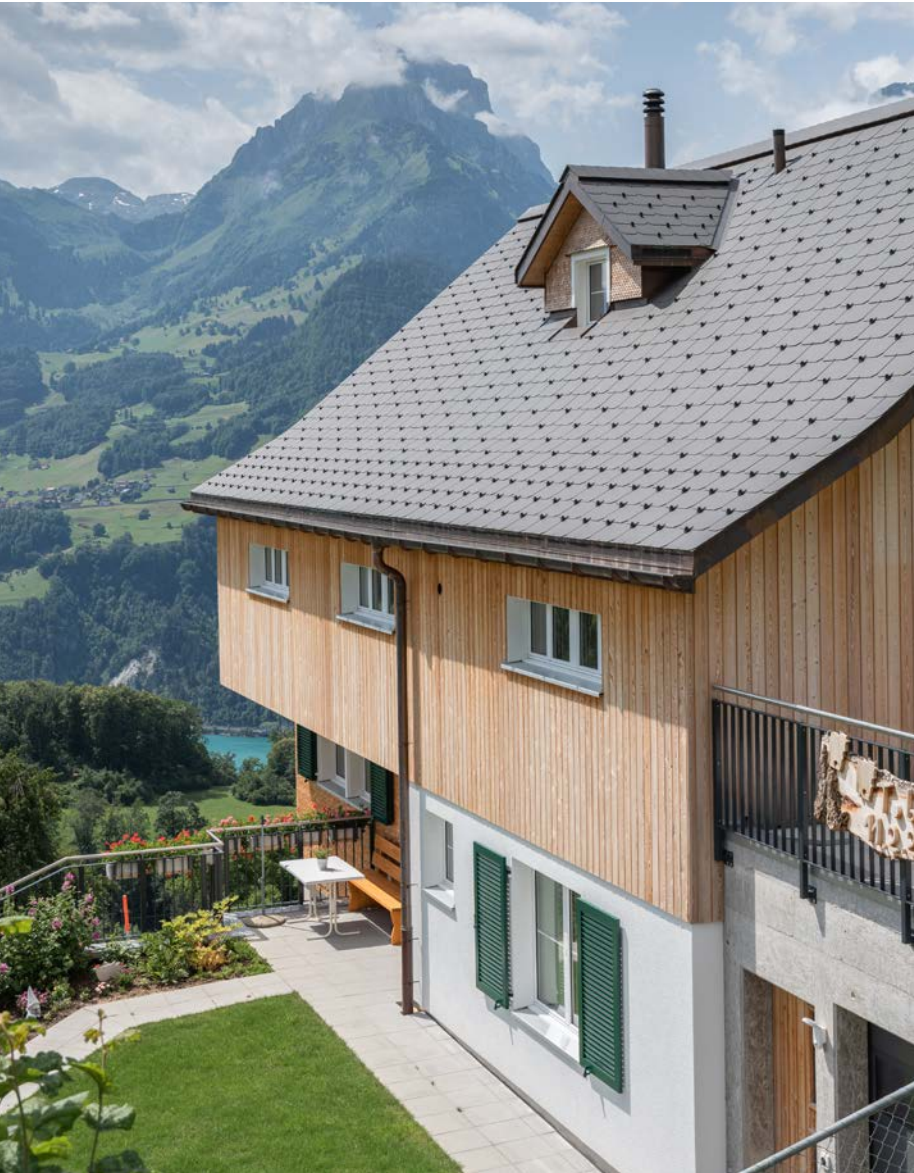
Maison individuelle, Amden. Ardoises de toiture, famille de teintes : Natura. Architecture : RWPA Architektur GmbH ETH ZFH SIA, Winterthur. Photographie : Swisspearl Suisse SA
