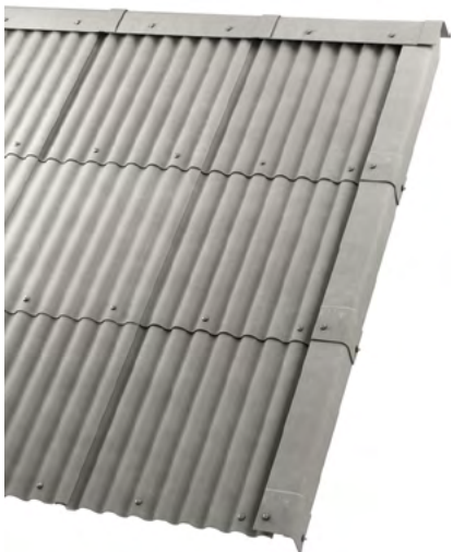
38 pav. Vėjalenčių montavimo būdas.
