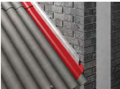
45 att. Jumta malas un sienas saskares vietas apdare.
