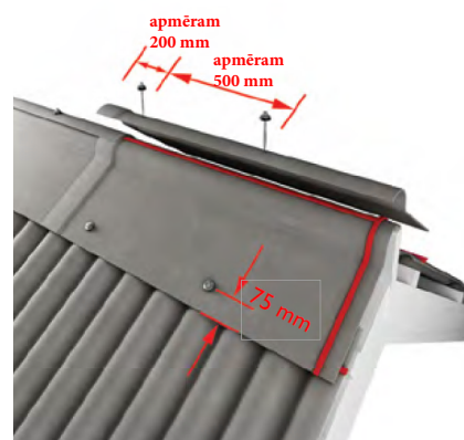
36. att. Regulējama kores elementa montāža.
