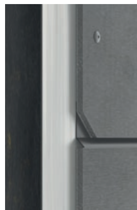
Listalla tiivistetty liitos
