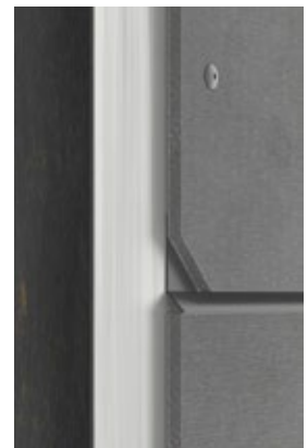
Listalla tiivistetty liitos
