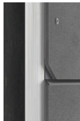
Listalla tiivistetty liitos
