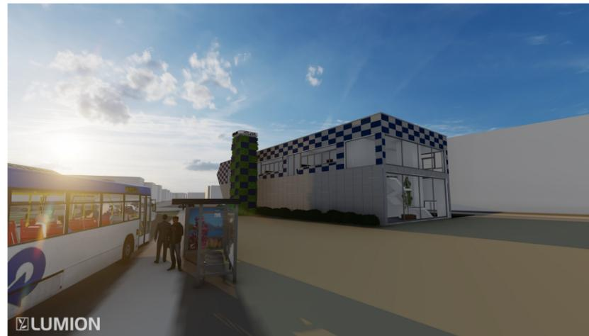
Es wurde auf eine nachhaltige Planung gesetzt. Als tragende Konstruktion wurde eine Holzriegelbauweise herangezogen, zusätzlich mit den Eternit-Platten verkleidet, für eine bessere Optik. Weiters wurde der bereits bestehende Turm neu aufgearbeitet.
