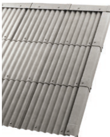
38. att. Vējmalu montāža.
