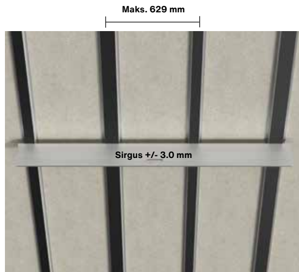
Aluskonstruktsiooni sirgus
