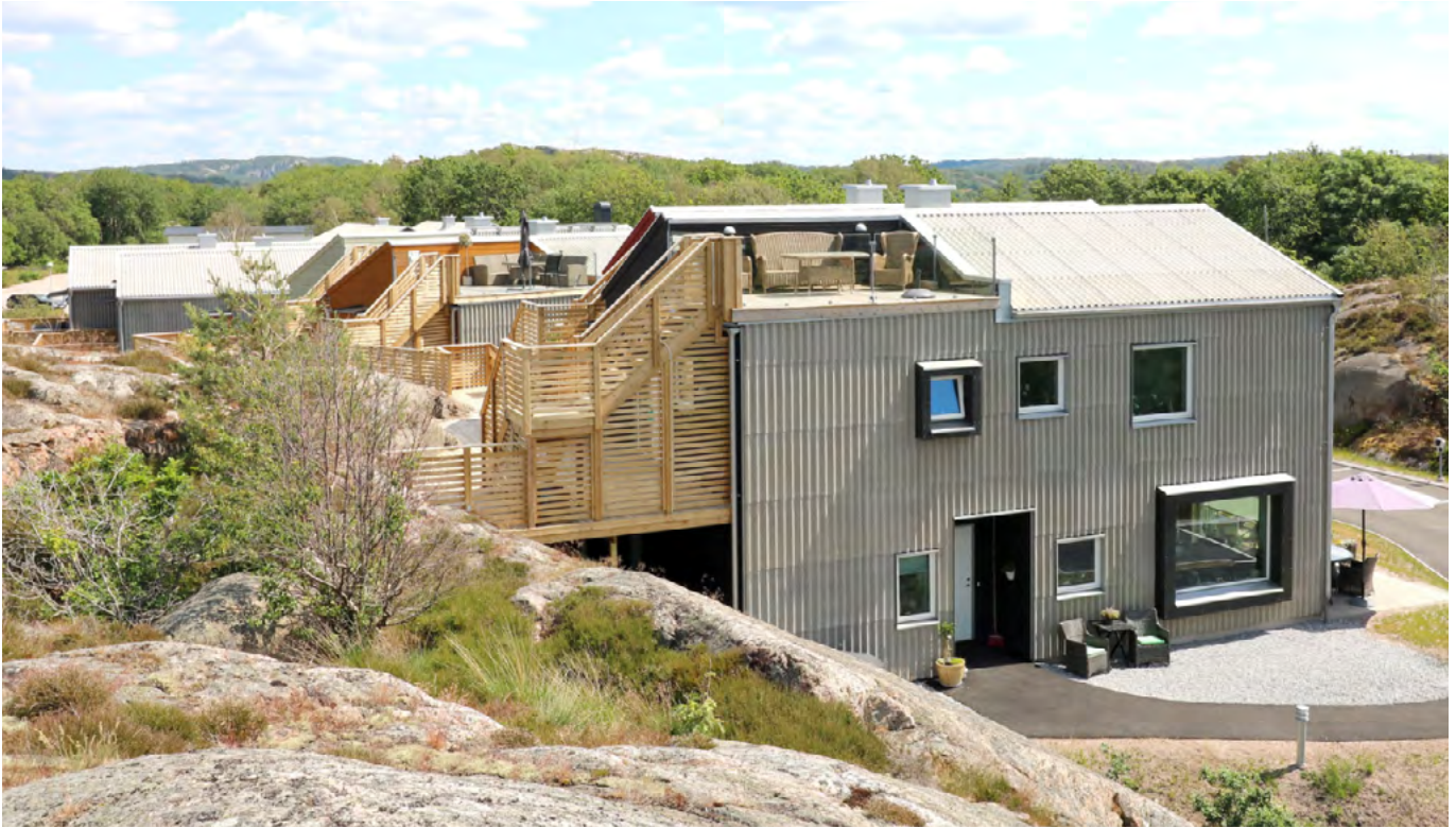
Brf Utskikten, Sweden. Architect: Cia Callermo och Yes Arkitekter, Uddevalla, Sweden. Builder: Per Jacobsson Byggnads AB, Hjärteby, Sweden.
