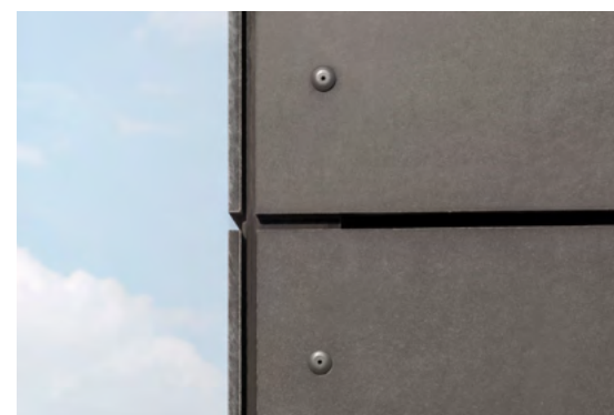
Sichtbare Befestigung der Faserzementplatten mit eingefärbten Nieten
