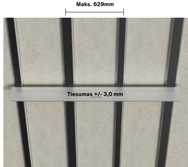
Pagrindo konstrukcijos tiesumas
